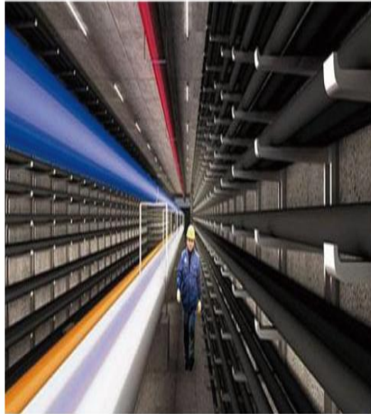
江北综合管廊基坑监测
